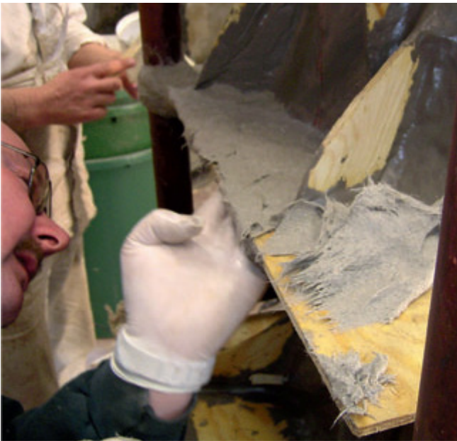
19 Vahvikkeen asennus EP-F Type VB -tukimateriaalilla
